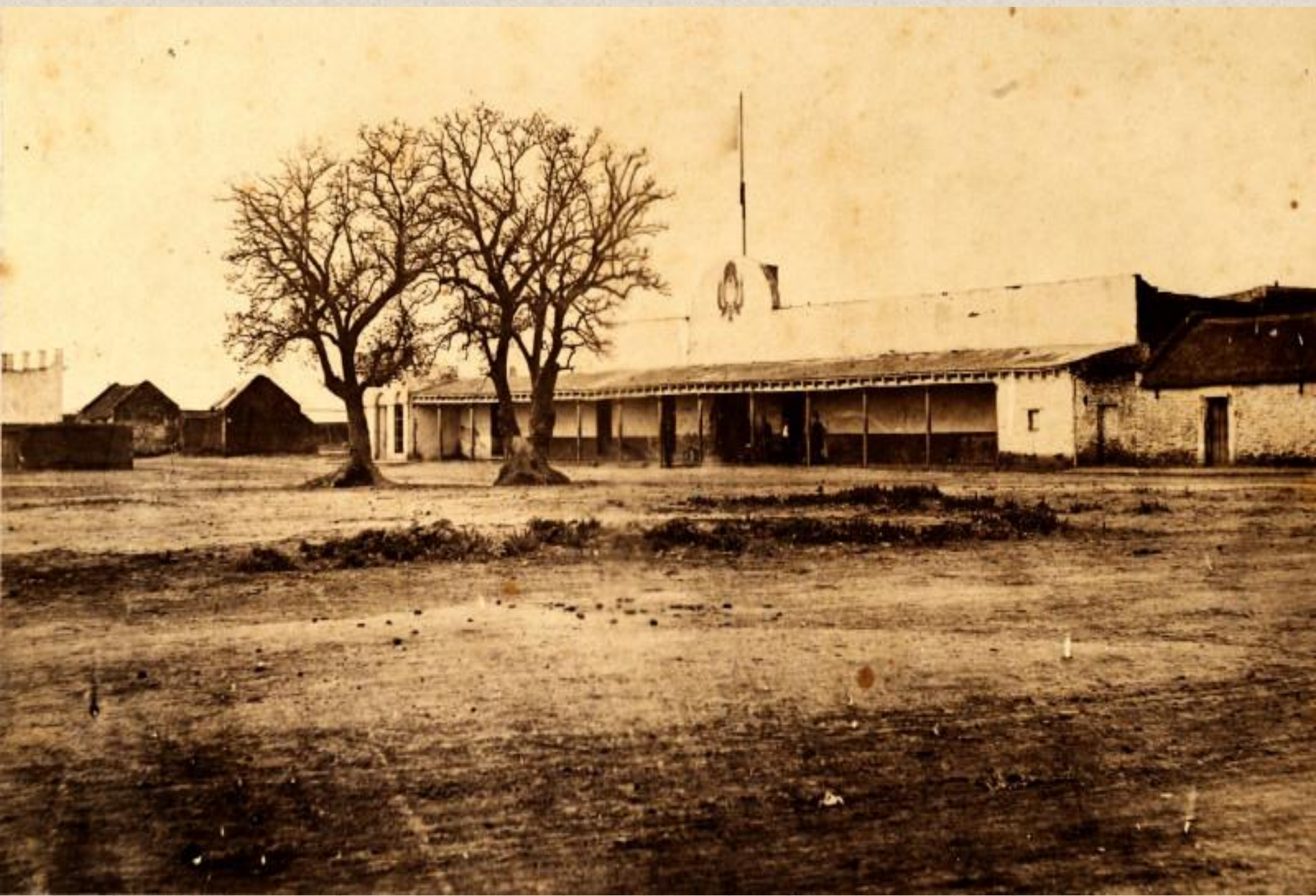
VISTA DEL CUARTEL
